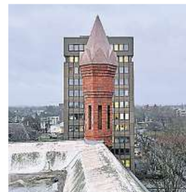
Einer der ersten fertigen Türme auf dem Dach. FOTO: STADT MÖNCHENGLADBACH
