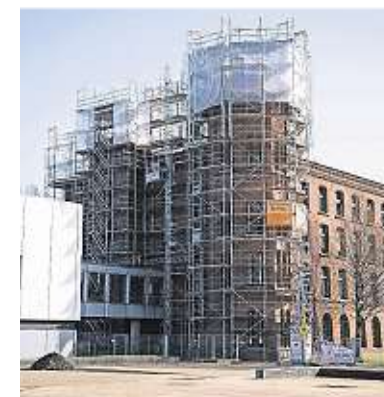
An anderen Ecken dauern die Bauarbeiten noch an. FOTO: JANA BAUCH
